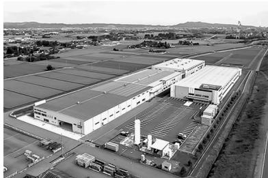
鉄道車両、建設機械などのインフラ産業に使われる軸受用部品を製造しているNSK富山は、高岡工場の新棟(富山県高岡市戸出徳市188-2)を竣工した。生産品目は軸受用の鍛造加工品と旋削加工品で、建築面積は1万9311平方メートル。
